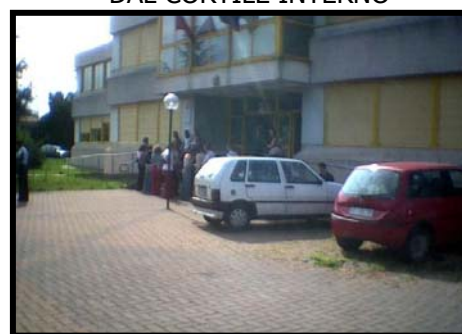
LA SEDE PRINCIPALE DI VIA GALVANI DAL CORTILE INTERNO
